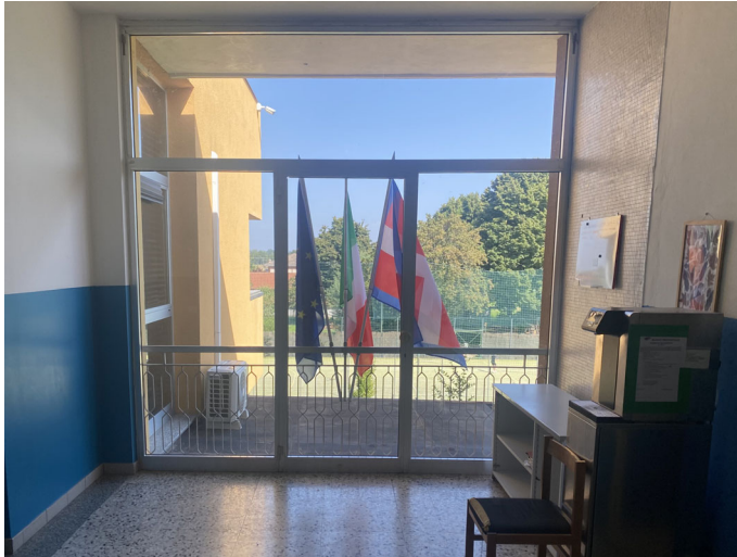
Figura 9 – Serramento esistente al piano primo in corrispondenza del futuro collegamento alla nuova via di esodo.
