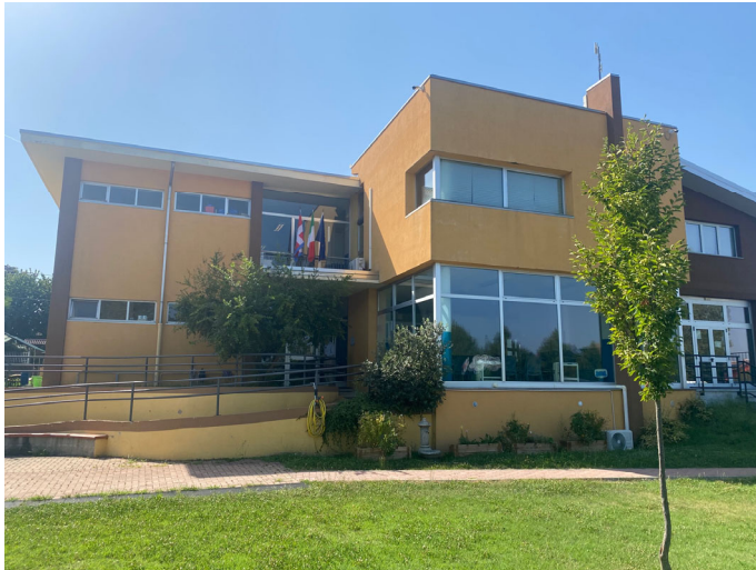
Figura 7 – Vista del fronte interessato dall'intervento e delle sistemazioni esterne esistenti.
