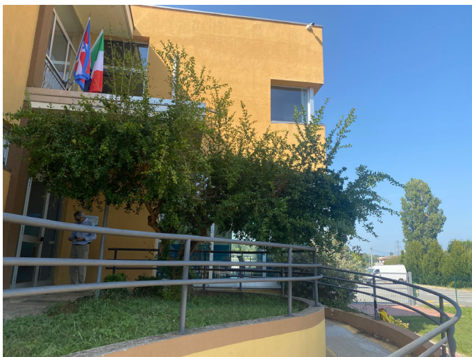
Figura 8 – Area esterna nella quale è prevista la realizzazione della nuova scala di sicurezza.
