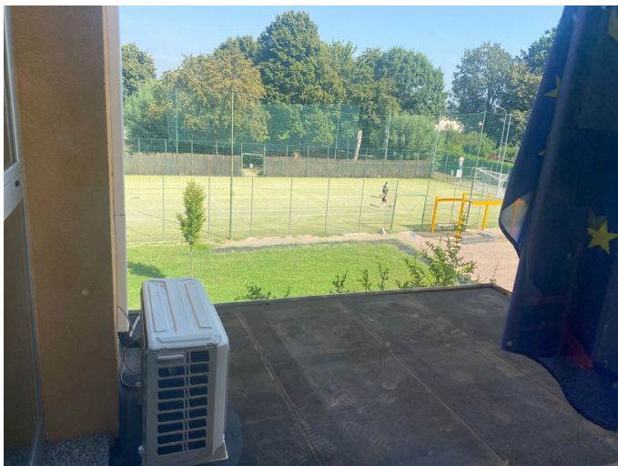
Figura 10 – Stato attuale del pianerottolo esterno e unità impiantistica interferente con le opere di progetto.
